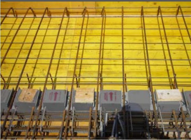
03. Posa dell'armatura di completamento dello sbalzo (momento negativo)
