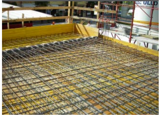
04. Posa dell'armatura di ripartizione del solaio (rete)
