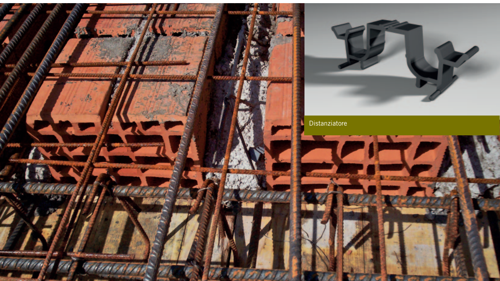
Non c'è interferenza con l'armatura dei cordoli e delle travi
