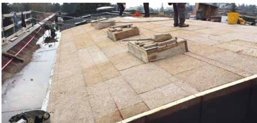
Figura 1 - Posa in opera di pannelli Xilite Comfort per intervento su una copertura esistente
