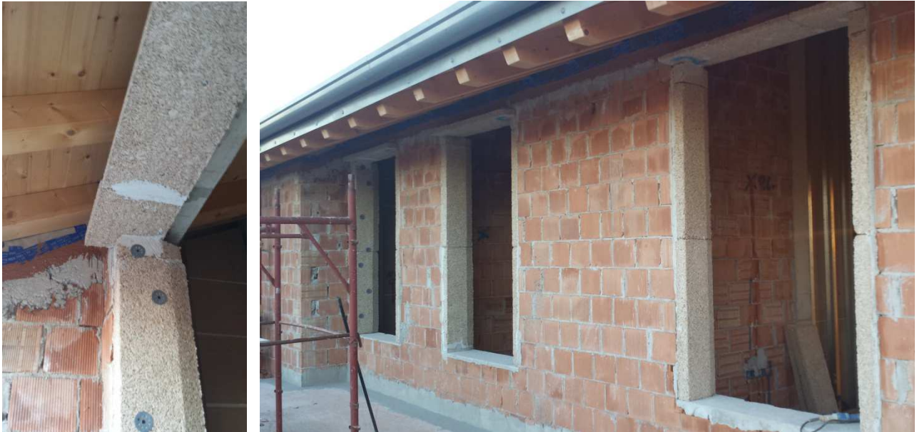
Fase 3: Installazione dei pannelli superiori ed inferiori (se previsti) e stuccatura delle fughe.
