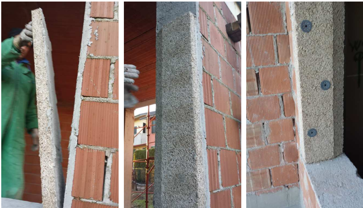
Fase 2: incollaggio del profilo sulla spalla con pressione fino ad ottenere rifiuto del collante e successiva tassellatura con tasselli da cappotto a taglio termico.
