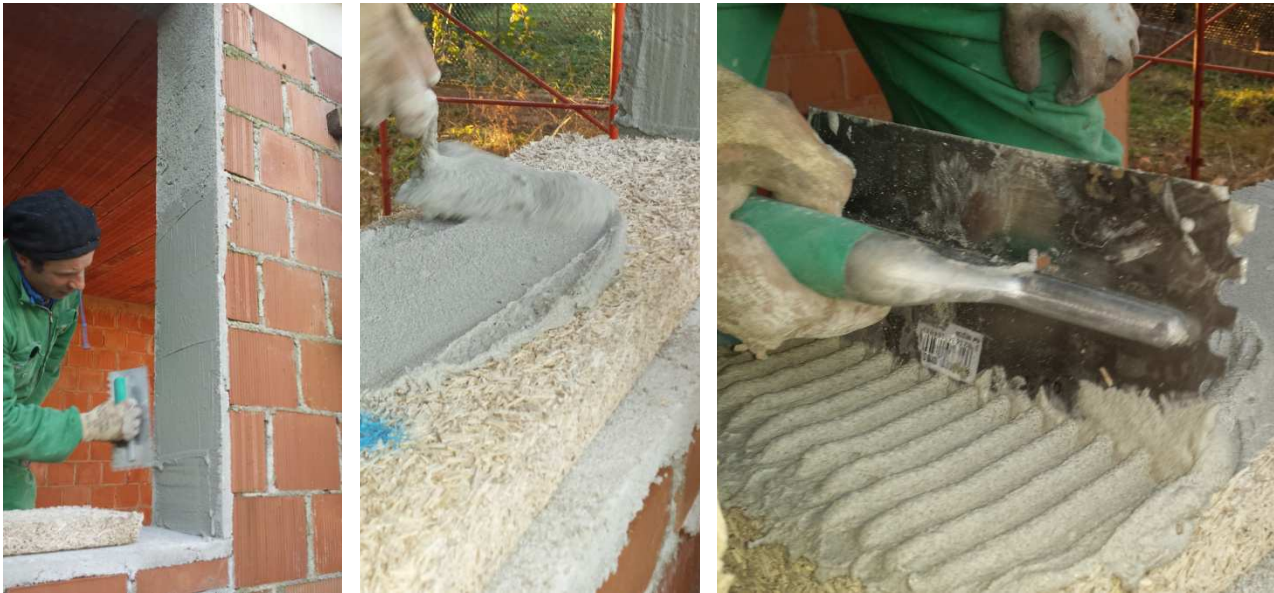
Fase 1: preparazione del collante sulla superficie di posa e sulla superficie di Xilite da incollare.
