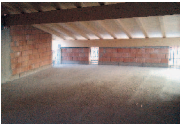
Isolamento della parete con XILITE® BLOCK al piano terra e nel sottotetto
