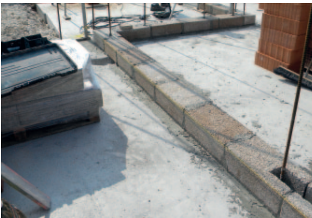
Tracciamento e posizionamento del primo corso
