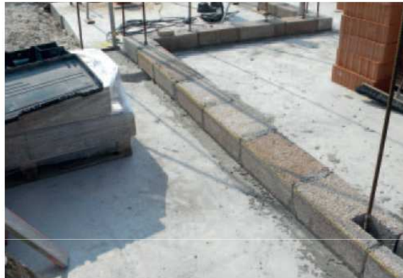
Tracciamento e posizionamento del primo corso
