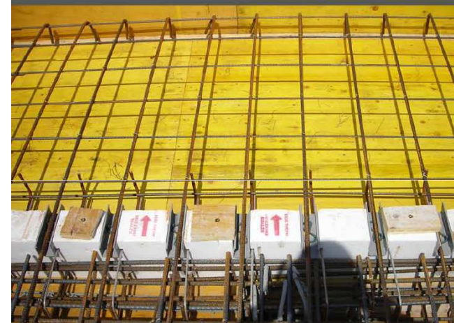
03. Posa dell'armatura di completamento dello sbalzo (momento negativo)
