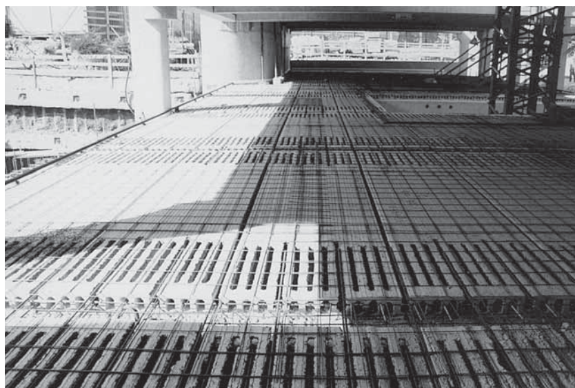
Fig. 4.16 Testata predisposta per il getto di un'ala collaborante piuttosto estesa.
