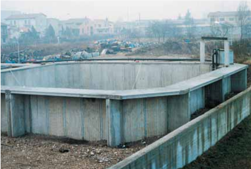
Fig. 1.3 Le pareti alveolari per una vasca di depurazione acque
