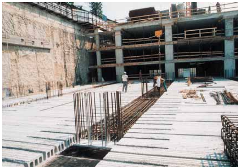
Fig. 1.2 I solai alveolari in una autorimessa sotterranea pluripiano
