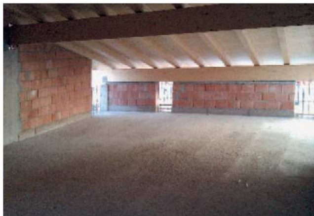
Isolamento della parete con XILITE® BLOCK al piano terra e nel sottotetto
