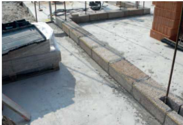
Tracciamento e posizionamento del primo corso
