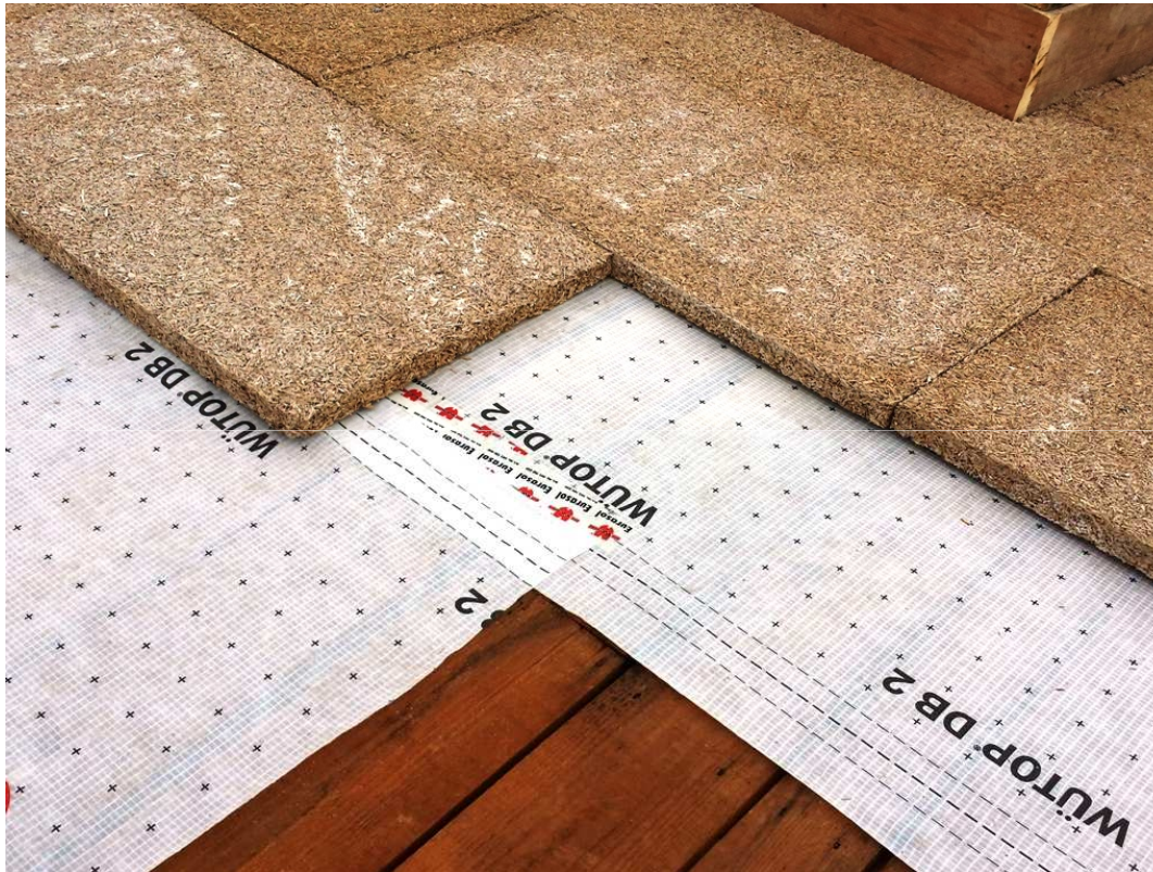
Posa del freno vapore e dei pannelli Xilite Comfort 4 cm
