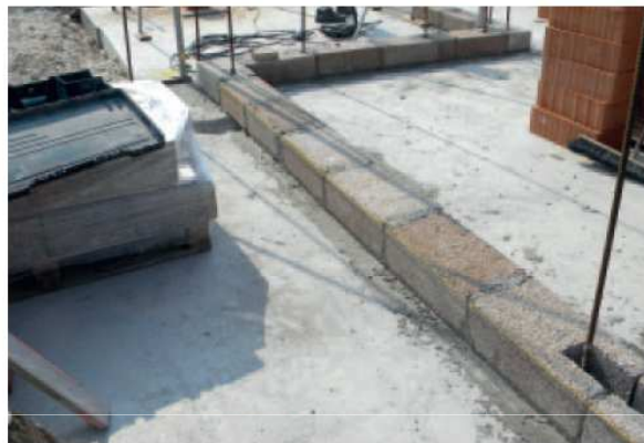
Tracciamento e posizionamento del primo corso
