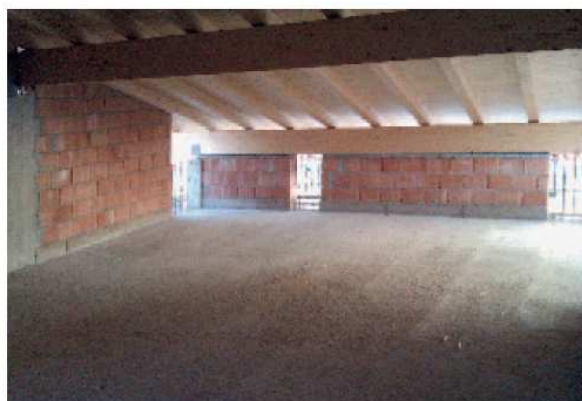
Isolamento della parete con XILITE® BLOCK al piano terra e nel sottotetto
