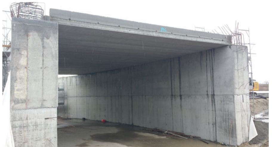
Sottovia autostradale a sezione scatolare dell'interconnessione A4-A13 a Padova.
