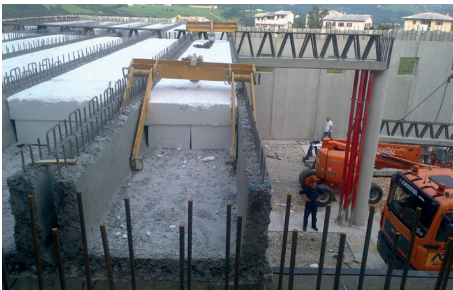
Utilizzo di blocchi di EPS posizionati all'interno della sezione ad U.
