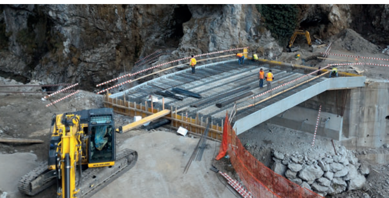
Ricostruzione di un impalcato da ponte distrutto da una frana a Serina (BG).
