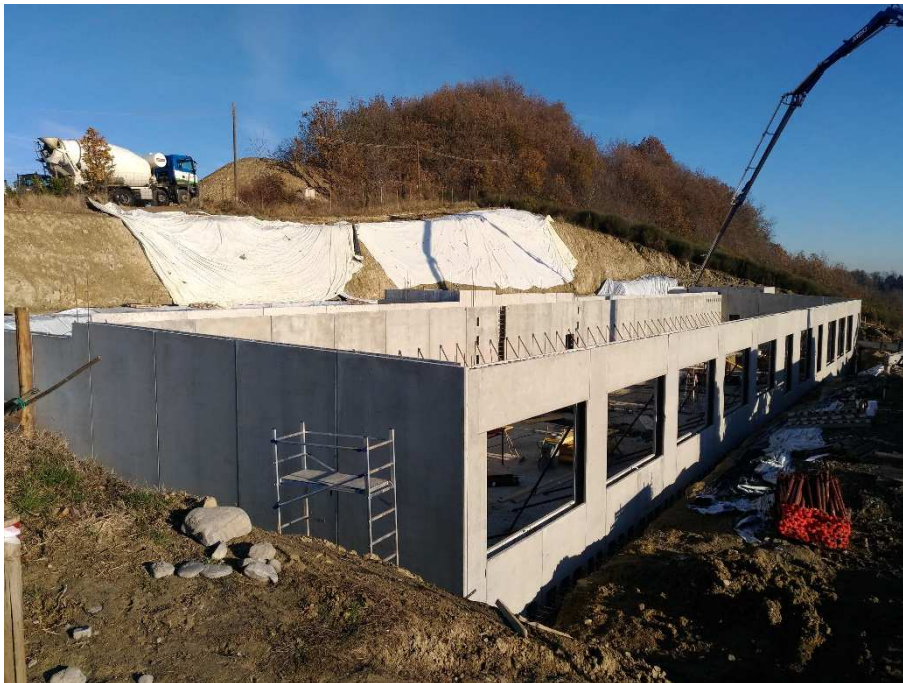
Posa dei muri perimetrali del piano terra
